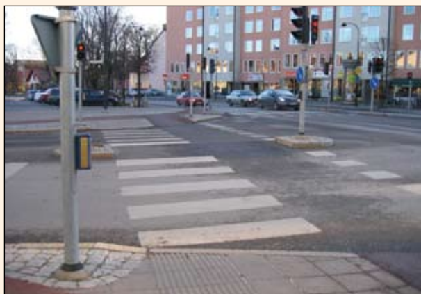
Övergångsställe vid Drottninggatan som bör åtgärdas.
