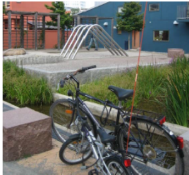
Dagvattenhantering i kombination med växtlighet. Detta kan vara ett lämpligt sätt att fördröja avrinningen till det allmänna ledningsnätet och samtidigt få ett tilltalande gröningslag i stadsmiljön.
