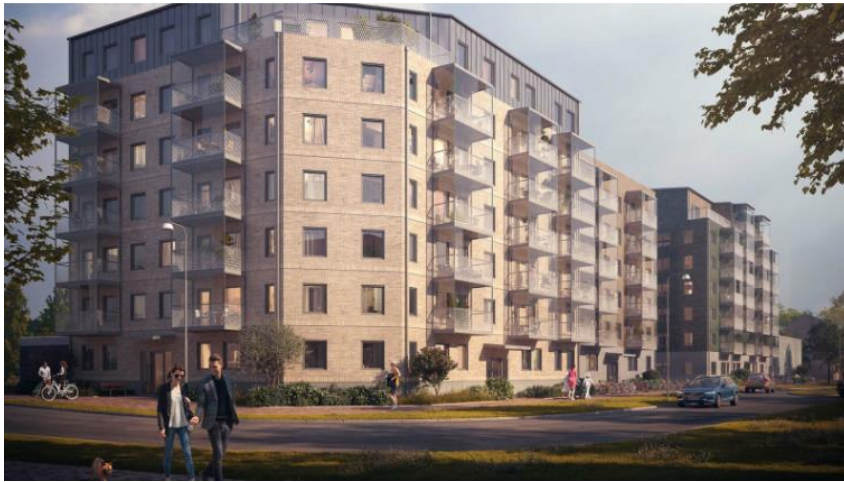
Visionsbild över pågående byggnation av kvarteret Labbet, Stångåstaden 2023
