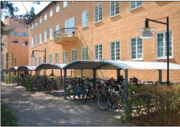
Väderskyddade cykelparkeringar för Polisens anställda.
