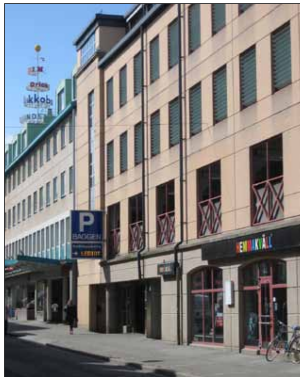
Parkeringshuset Baggen följer upp intilliggande byggnads våningsindelning och har lokaler i bottenvåningen som gatumiljön mer levande.
