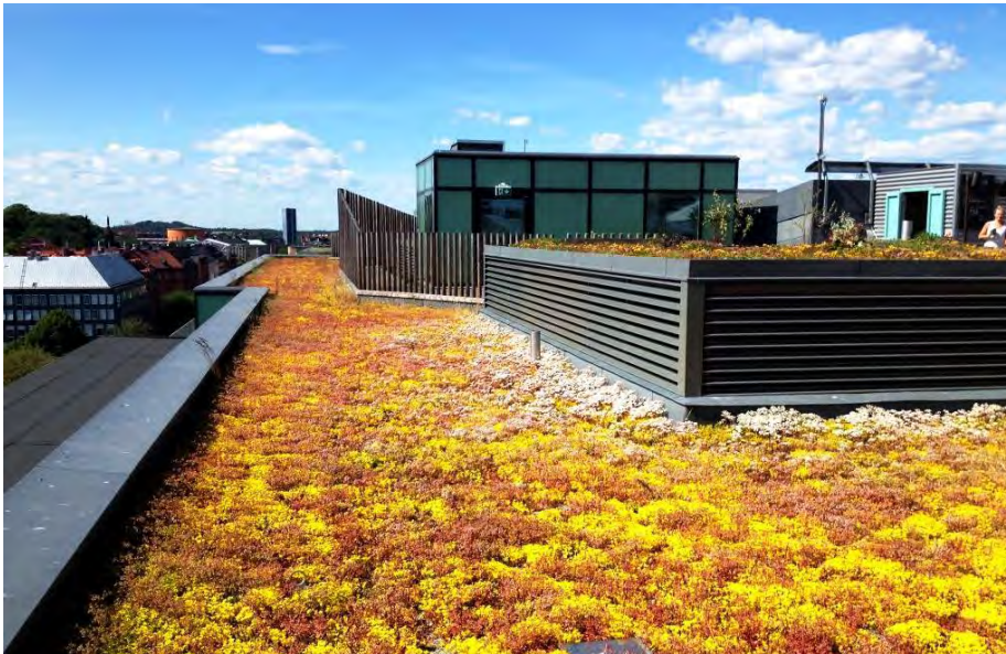
Figur 4. Exempel på LOD. Grönt (gult) tak (VA-guiden, 2016 1 ).
