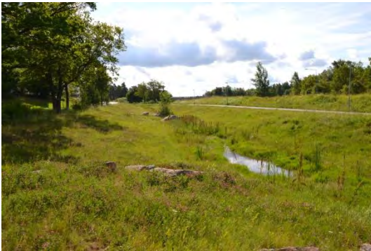
Figur B. Exempel på trög avledning av dagvatten. Dagvattendike utmed Haningeleden i stadsdelen Hagaberg. Foto Linköpings kommun.
