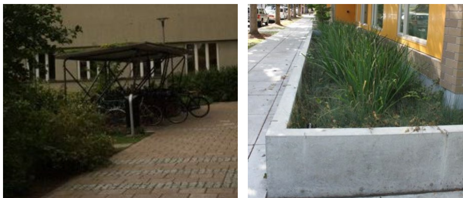
Exempel på dagvattenanläggningar, vegetationsklätt tak och upphöjd växtbädd (WRS, 2020).
