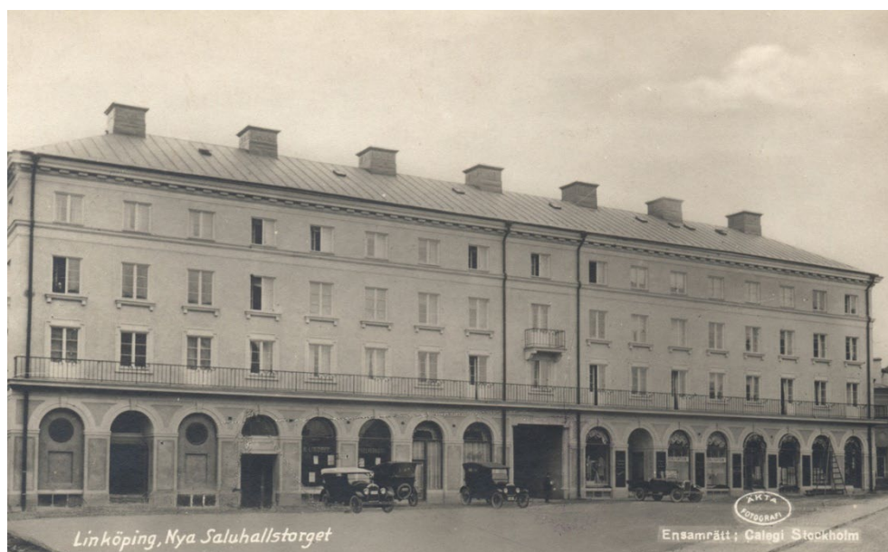
Delfinpalatsets utseende vid byggnadens uppförande år 1927.
