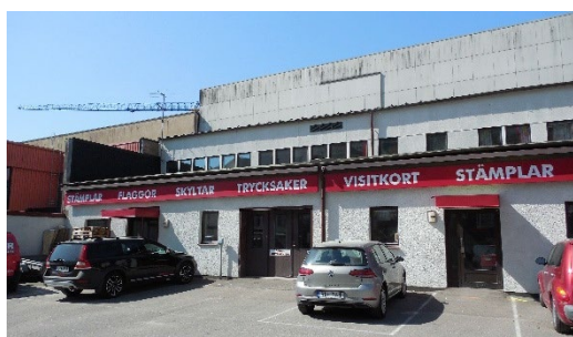
Foto 2: Stämpelfabriken. Byggnaden är avgränsad med brandmurar till angränsande byggnader.
