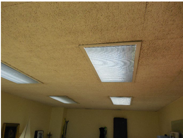
Figur 5. Lysörnsarmaturer av äldre modell. Dessa har inbyggda kondensatorer som misstänks kunna innehålla PCB.
