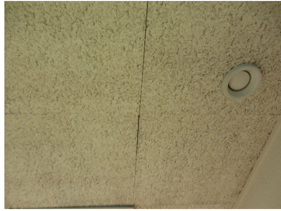
Figur 4. Undertak plan 1 trp Beridaren 6. Asbestförekomst ej påvisad
