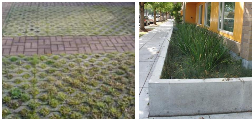
Exempel på hantering av dagvatten. Första bilden visar exempel på genomsläpplig beläggning och andra bilden visar exempel på upphöjd växtbädd (WRS, 2018).
