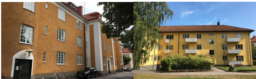
Bild. Kasernbyggnaderna utmed Skyttegatans södra sida uppförda 1917-22 och bostadshuset från 1950-talet på den norra sidan om gatan.
