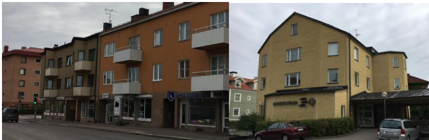
Bild. Bostadshusen i kvarteret Emiren (korsningen Djurgårdsgatan/Lasarettsgatan) uppfördes under 1940–50-talen och är tidstypiska i sin utformning. Det gula tegelhuset uppfördes på 1980-talet och nyttjas som kyrkolokal och för bostäder.
