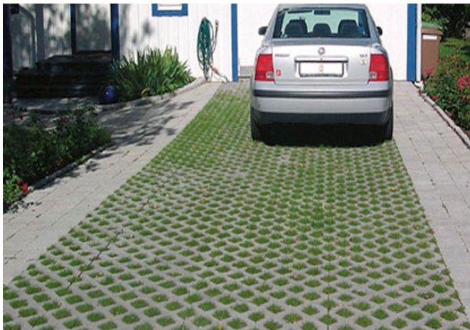
Figur 27 Gräsarmering på garageuppfart. Källa: www.alltimark.se
