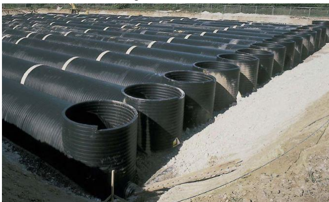
Figur 25 Rörmagasin. Källa: www.kwhpipe.se
