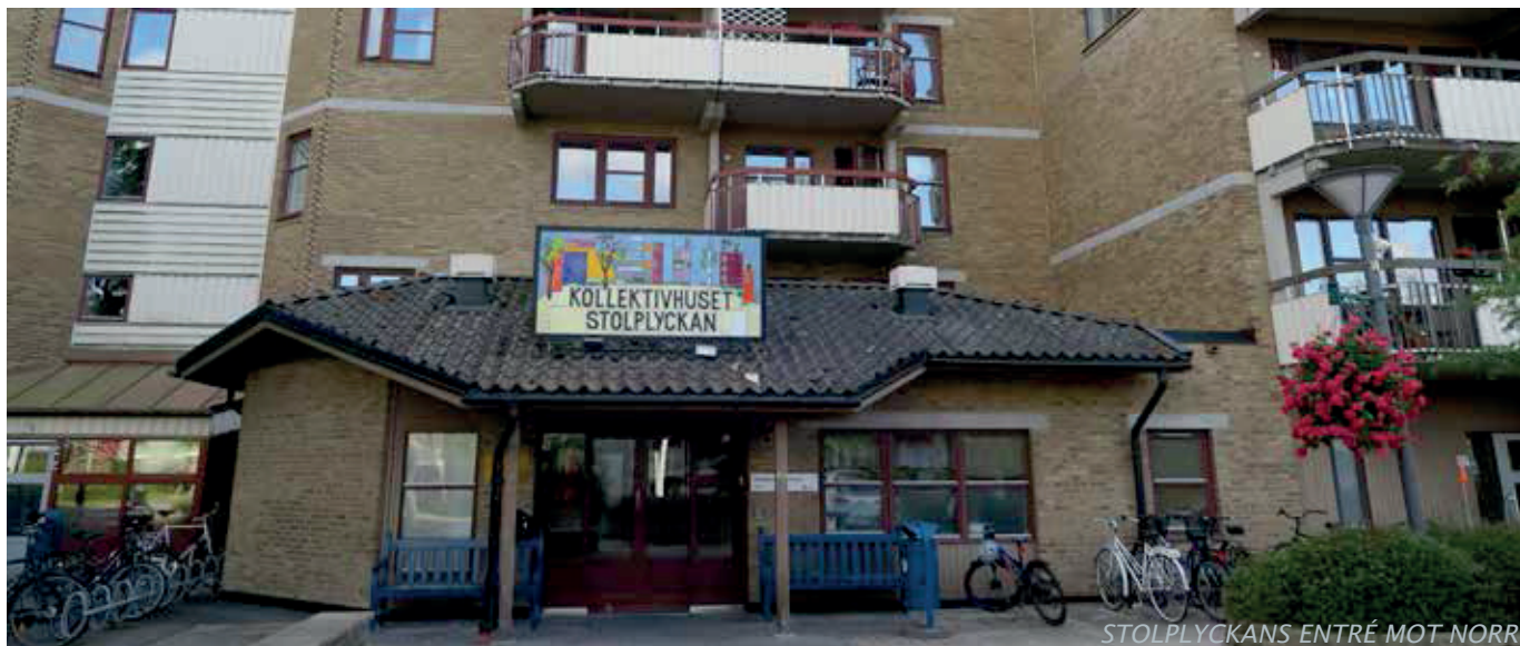
STOLPLYCKANS ENTRÉ MOT NORR.
