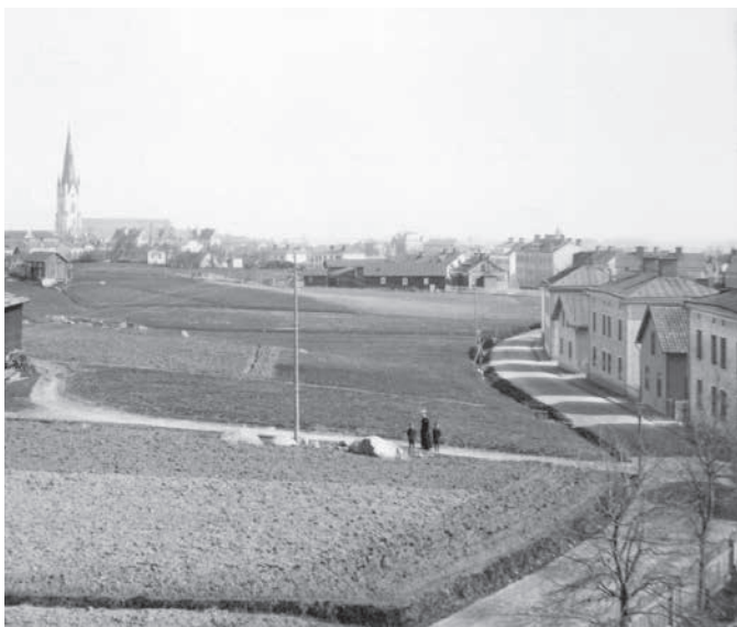
Djurgårdsgatan 1904. Foto taget från Kaserngatan/ Föreningsgatan mot nordost.
