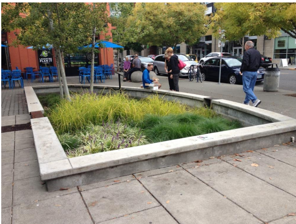
Figur 11. Exempel på dagvattenhantering i kombination med gestaltning av torgyta i en nedsänkt växtbädd. Foto: WRS.
