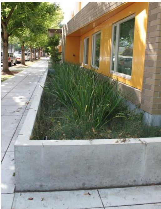
Figur 9. Exempel på upphöjd växtbädd. Observera att växtbäddar kan anläggas utan något behov av mur runt omkring. Foto: WRS
