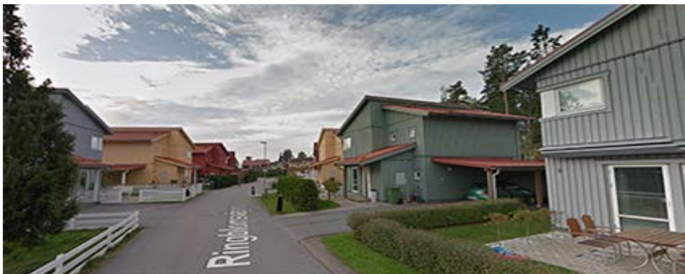
Gruppvis med varierad fasadkulör i två plan med sadeltak och ca 6 meters indrag från gata. Från Ringbomsvägen i Ullstämman. Bild från Google Maps.
