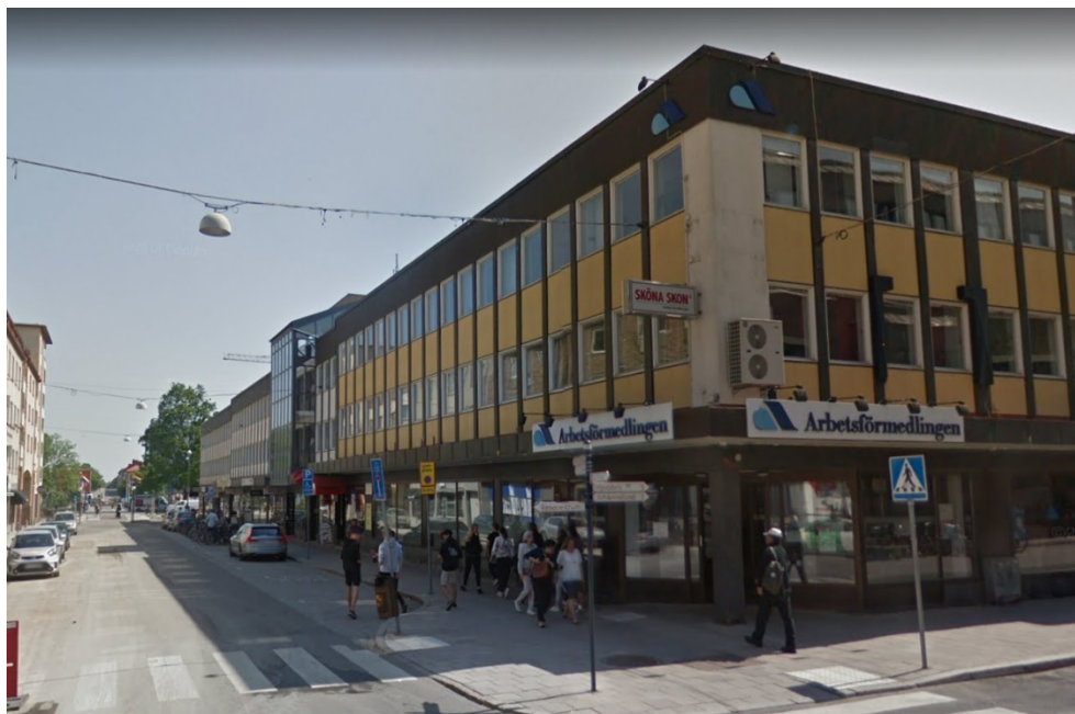
Foto av befintlig bebyggelse sett från väster/Storgatan, foto hämtat från Google.
