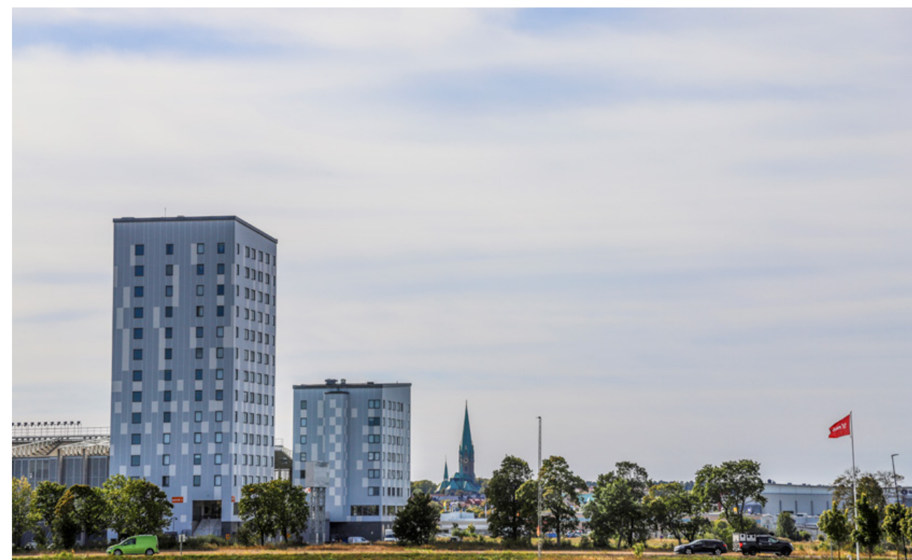
På Stångebro, mellan Saab arena och fotbollsarenan planeras en ny stadsdel och i den ska en gymnasieskola byggas.
