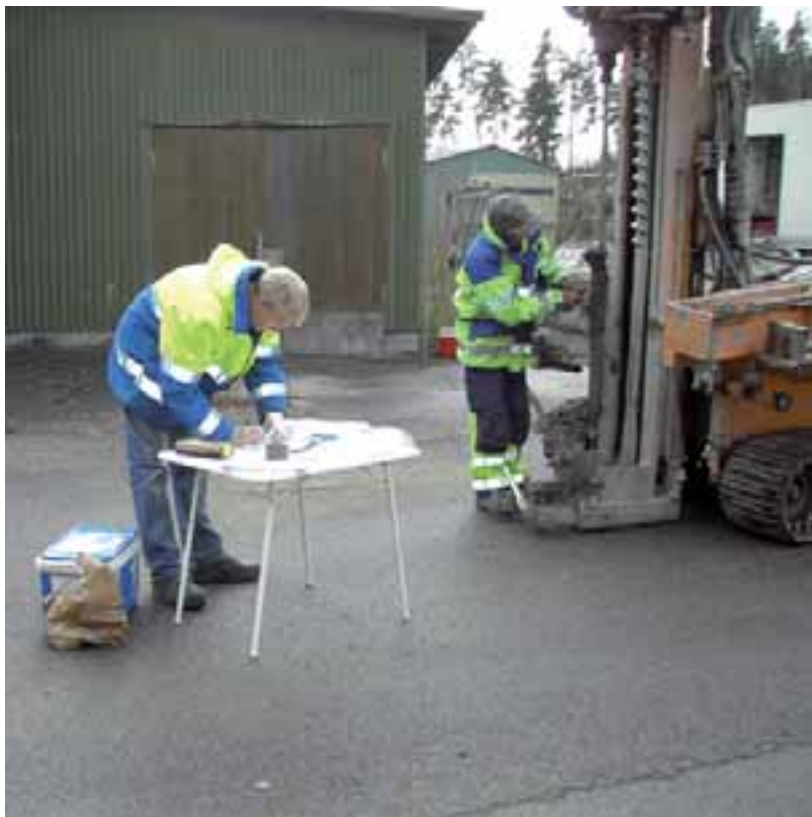
Jordprovtagning av förorenad mark med borrhandsvagn. Foto: Länsstyrelsen Östergötland
